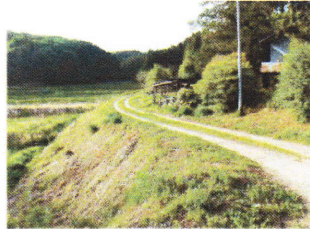
除染土を再利用して造成が計画されている市道 拡大写真
